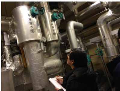
設備診断の様子
