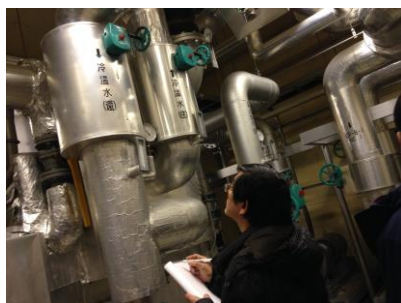
設備診断の様子
