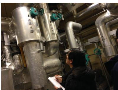
設備診断の様子
